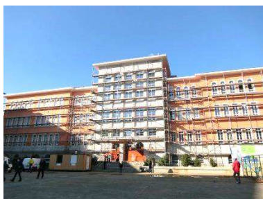
学校の外観 改修中である。
